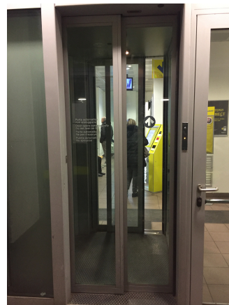
Figura 1: L'accesso automatizzato di un ufficio postale.
